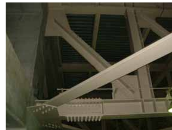
ボルト接合部
