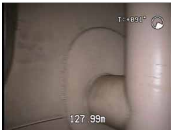
SGTS配管・筒身取合部
