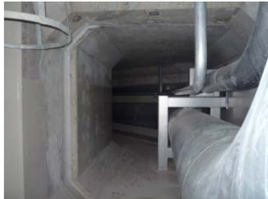
目地部の補修 ( 応急復旧状況 )
