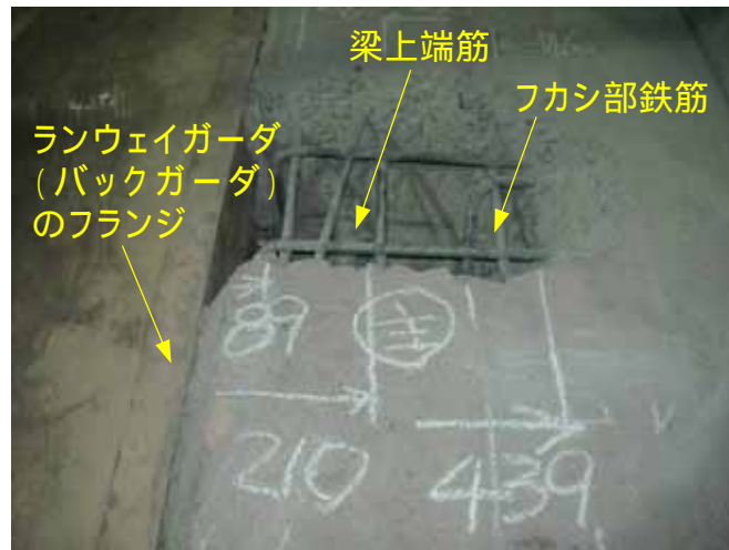
梁上面の鉄筋状況
