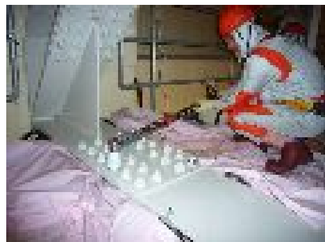
トルクレンチによる締付状況
