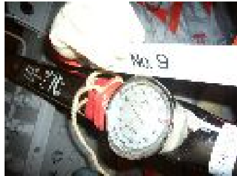
ボルト No.9 トルク確認状況
