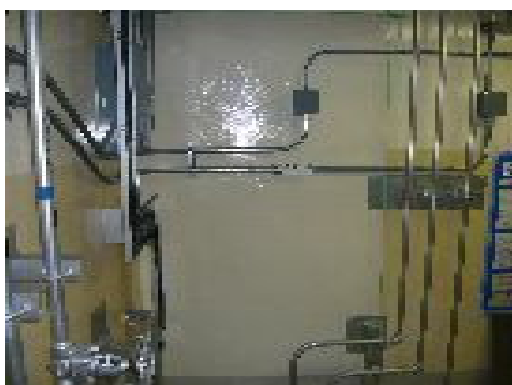
エポキシ樹脂塗装
