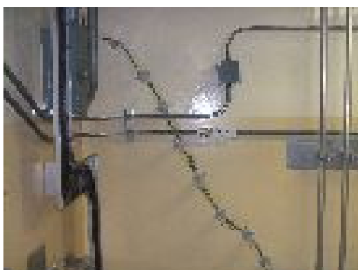
エポキシ樹脂注入
