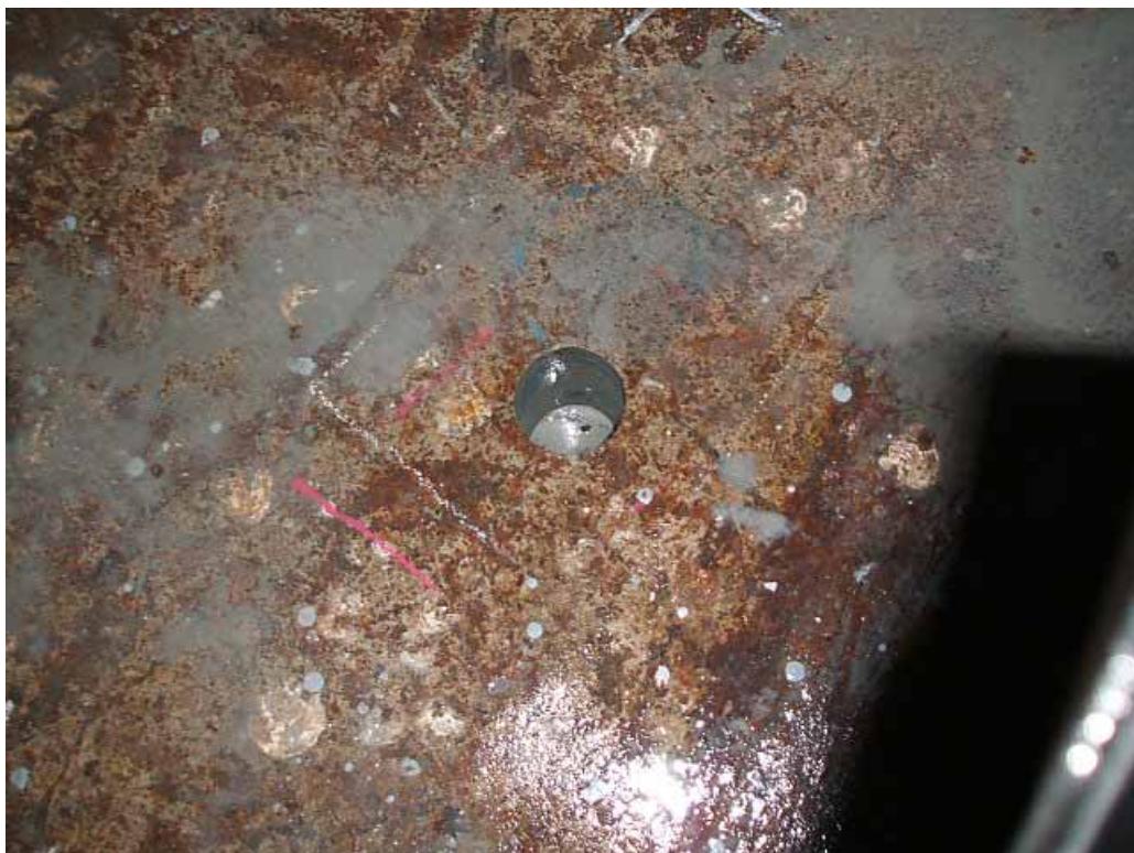
図-1.5 KK-6 T/B RSW(C)床面コアボーリング状況
