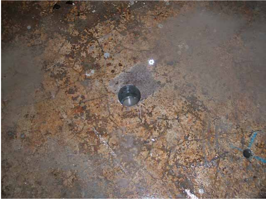
図-1.2 KK-6 T/B RSW(A)床面コアボーリング状況
