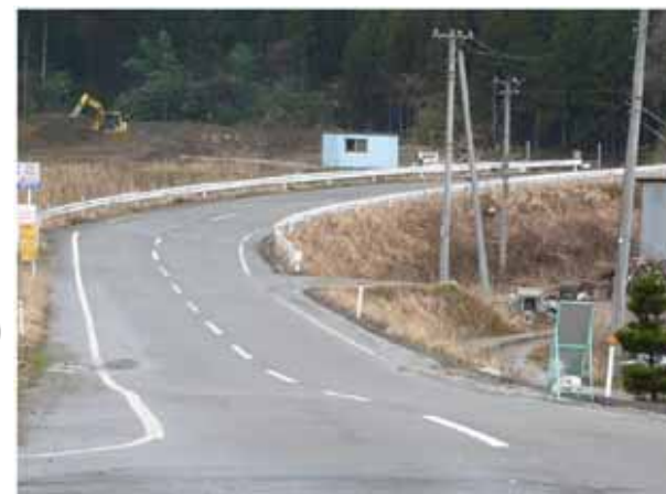
起点から2550m付近の盛土状況
