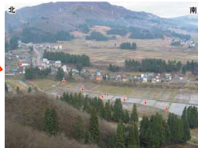
水田で確認された地震断層
