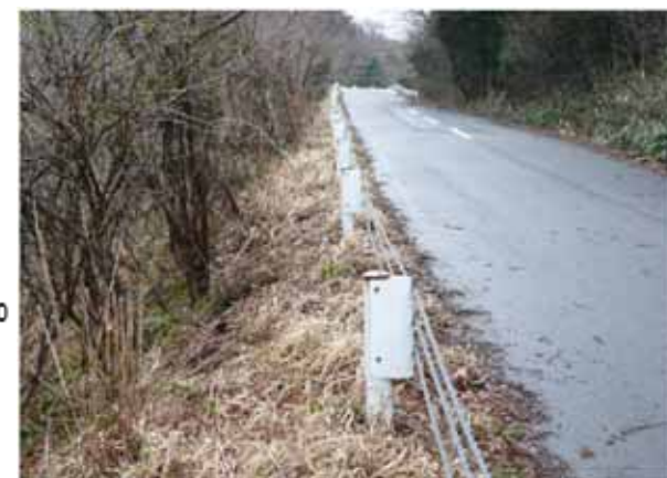
起点から1200m付近の盛土状況
