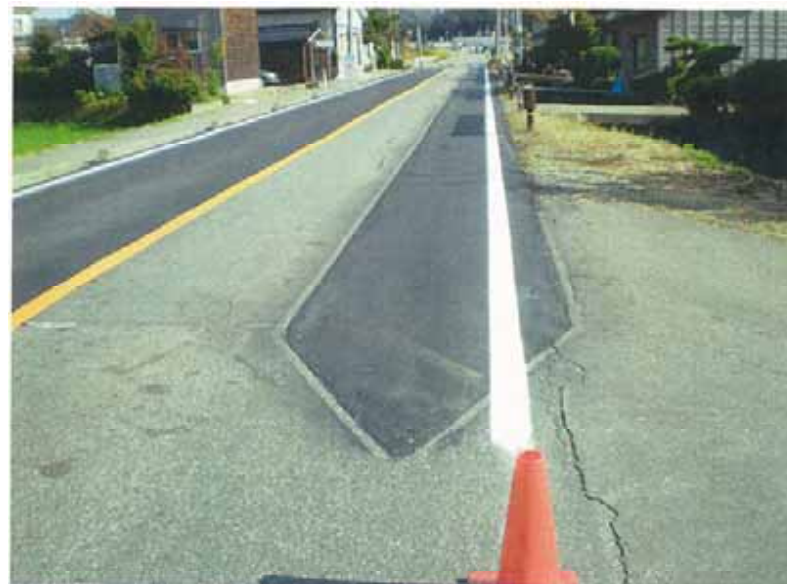
道路修復済箇所 (測量箇所 延長4100m付近) 海側から内陸側を撮影。測線は写真右側。
