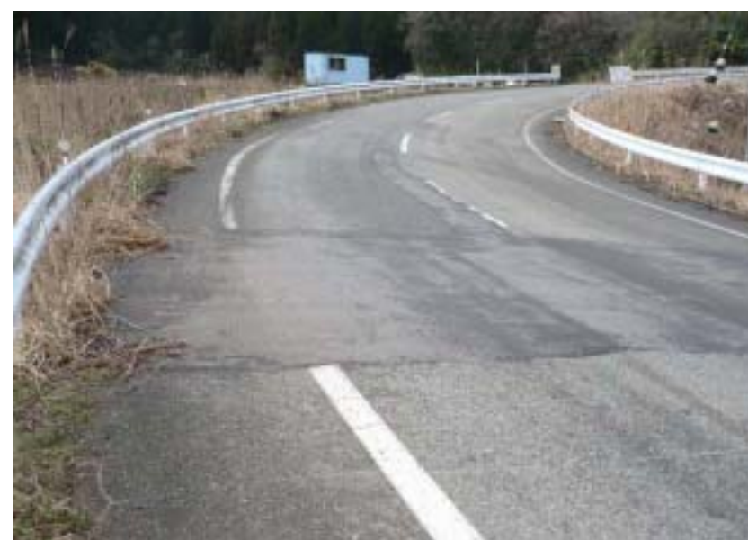
盛土における道路の補修状況
