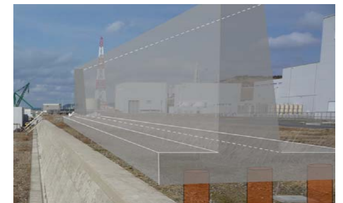
「地震・津波への対応強化」 柏崎刈羽における防潮堤の計画 (平成23年11月1日に着工)
