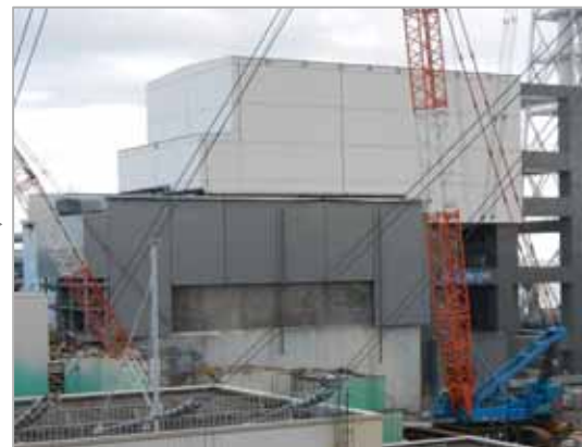
燃料取り出しカバーが設置された4号機
