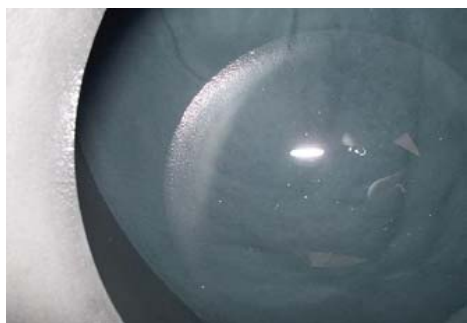
吸着塔 1 A 吸着材 4 (黒色) の上に白 い堆積物を確認
