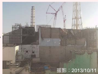
撮影: 2013/10/11 大型ガレキ撤去後
