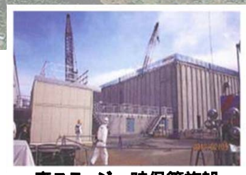
廃スラッジ一時保管施設
