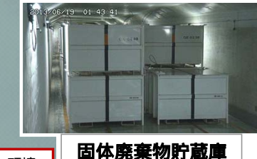
固体廃棄物貯蔵庫
