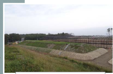
覆土式一時保管施設
