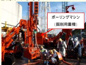
<陸側遮水壁 凍結管設置工事状況>
