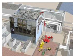
原子炉建屋上部のガレキ撤去
