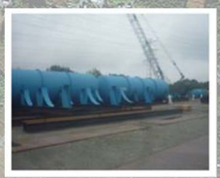
廃スラッジ一時保管施設
