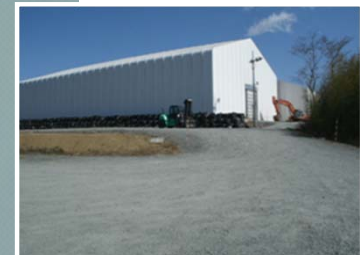
瓦礫保管テント
