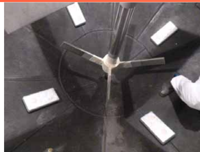
バッチ処理タンク1C (ゴムライニング施工後)
