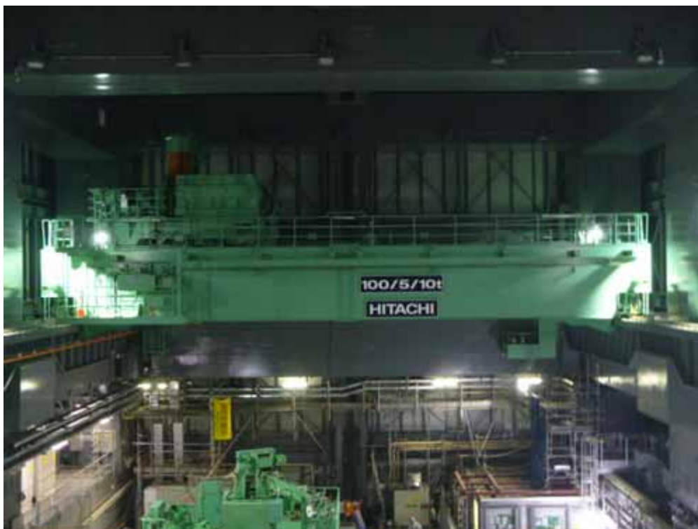
①天井クレーン全体（オペレーティングフロア北側より撮影）
