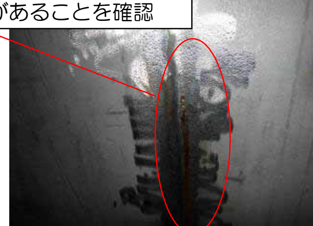
①タンク下部状況（拡大）
