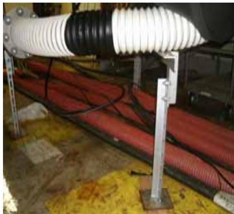
損傷箇所を粘着テープで養生し、漏えい封止
