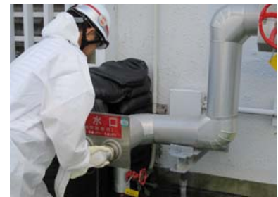
連結送水口への接続（1号機） (平成24年10月10日撮影)
