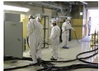
電源ケーブルの接続(2号機) (平成24年10月9日撮影)
