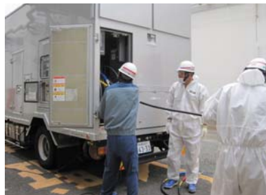
電源車の配備(2号機) (平成24年10月9日撮影)
