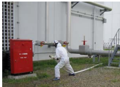
消火ホース（送水用）の引き回し（1号機） (平成24年10月10日撮影)
