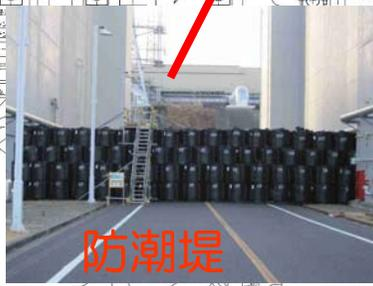
道幅2車線程度の開口部が2箇所設置されているが、土木学会の指針による想定津波高さ (O.P.+5.1m~+5.2m) に不確定性を勘案し (+9.5m) さらに、地盤沈下分を暫定的に (+0.7m) 考慮した浸水高O.P.+15.4mの津波が発生しても、防潮堤から山側については約60cm程度の浸水深さとなり、設備に被害を及ぼさない。
