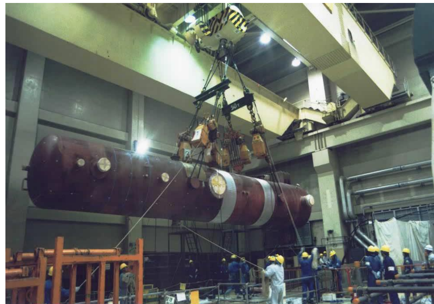
給水加熱器取替工事
