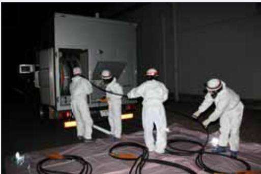
全交流電源喪失時に、原子炉、使用済燃料プールへの注水や除熱機能を維持するため、電源車を利用して必要な電源を供給する訓練を実施
