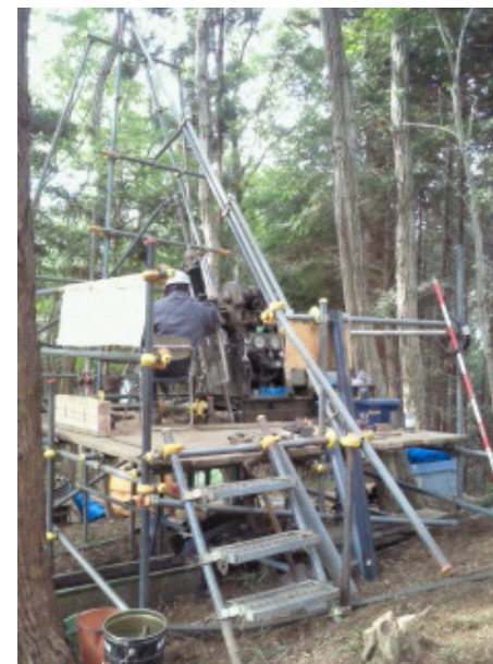
ボーリング調査状況写真
