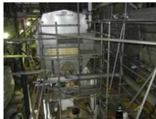
ディスクフィルター (除染装置) 平成23年6月5日 当社社員撮影
