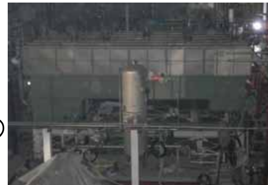
アレバ社 除染装置 (加圧浮上分離装置) 平成23年6月1日 当社社員撮影
