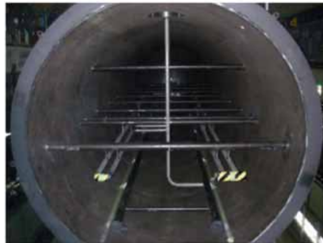
製作中の鉄製スラッジ貯蔵タンク (内部)
