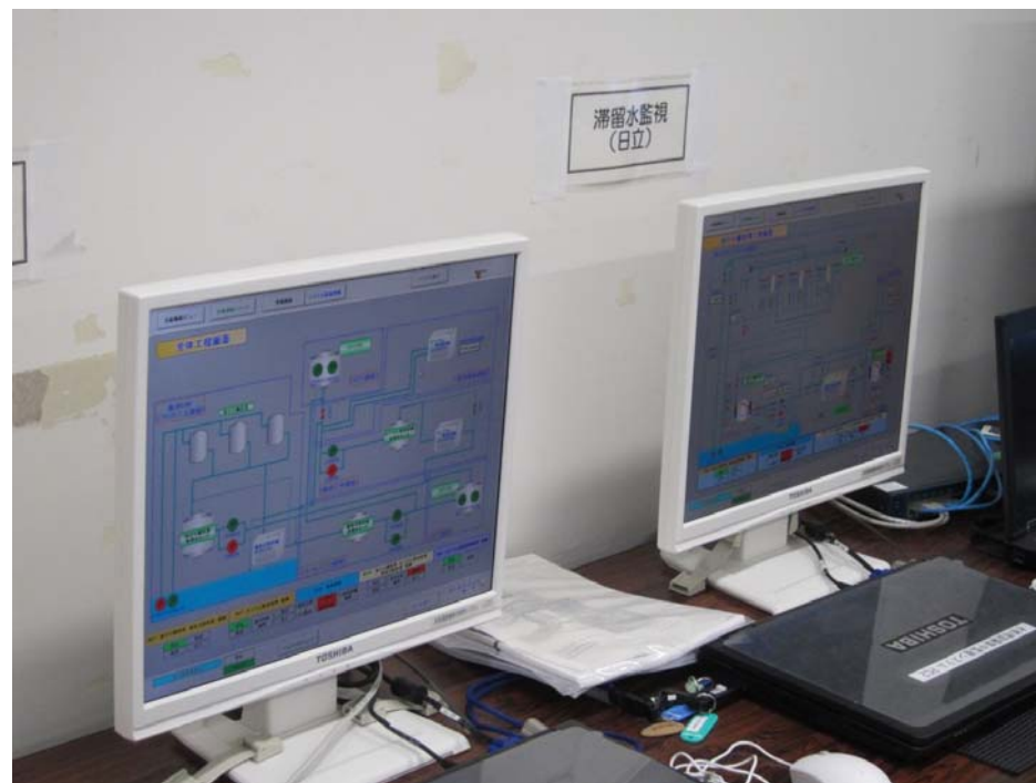
監視モニタ（免震重要棟）
