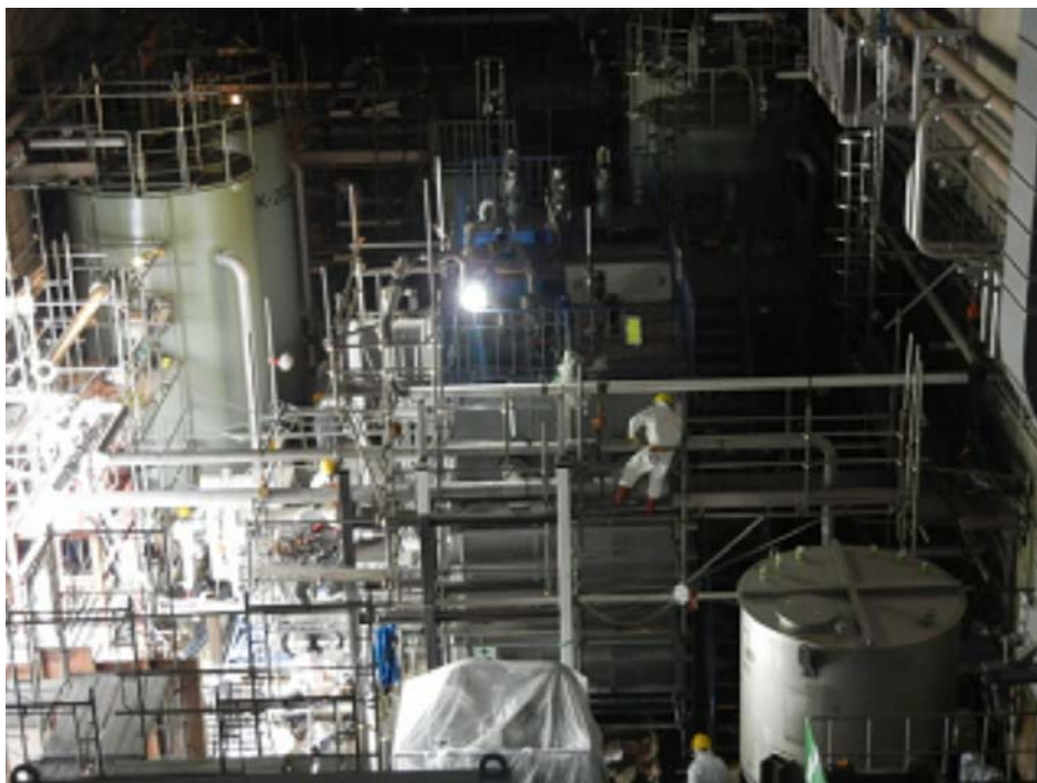
除染装置外観
