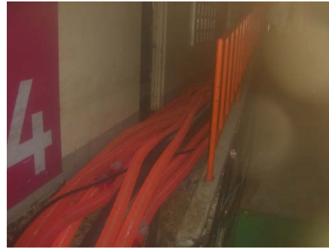
ホース設置状況 (タービン建屋～集中廃棄物処理施設) その2
