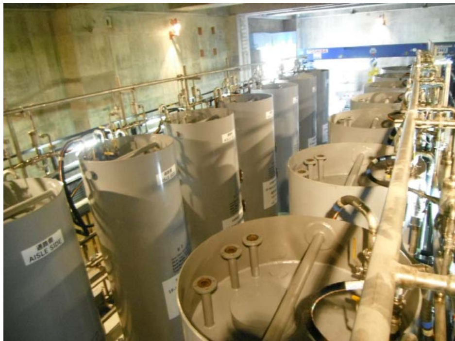
第二セシウム吸着装置（設置状況）その1
