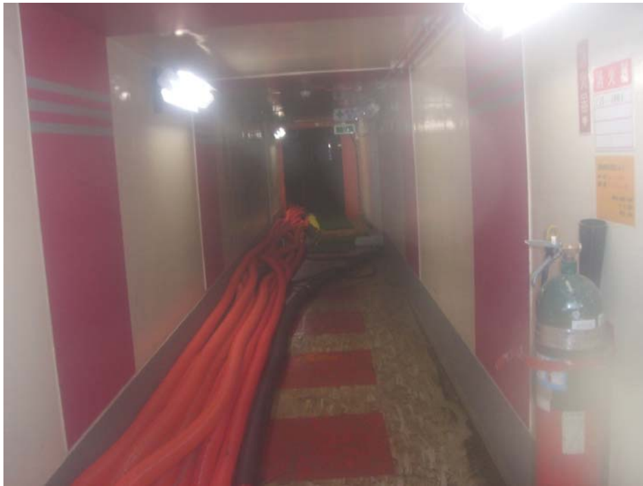
ホース設置状況 (タービン建屋～集中廃棄物処理施設) その1
