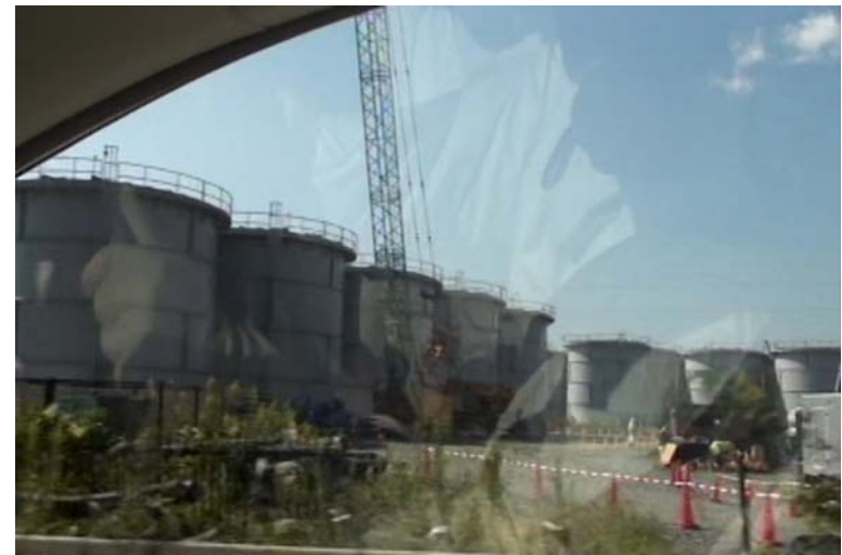
RO濃縮水貯蔵タンク その2
