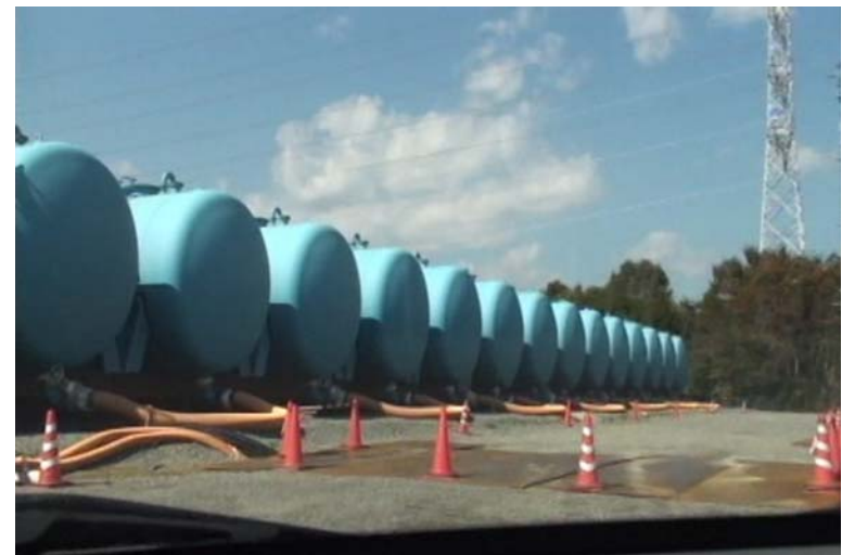
RO濃縮水貯蔵タンク その3
