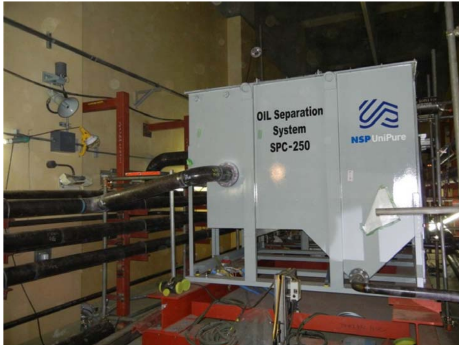
油分分離装置外観
