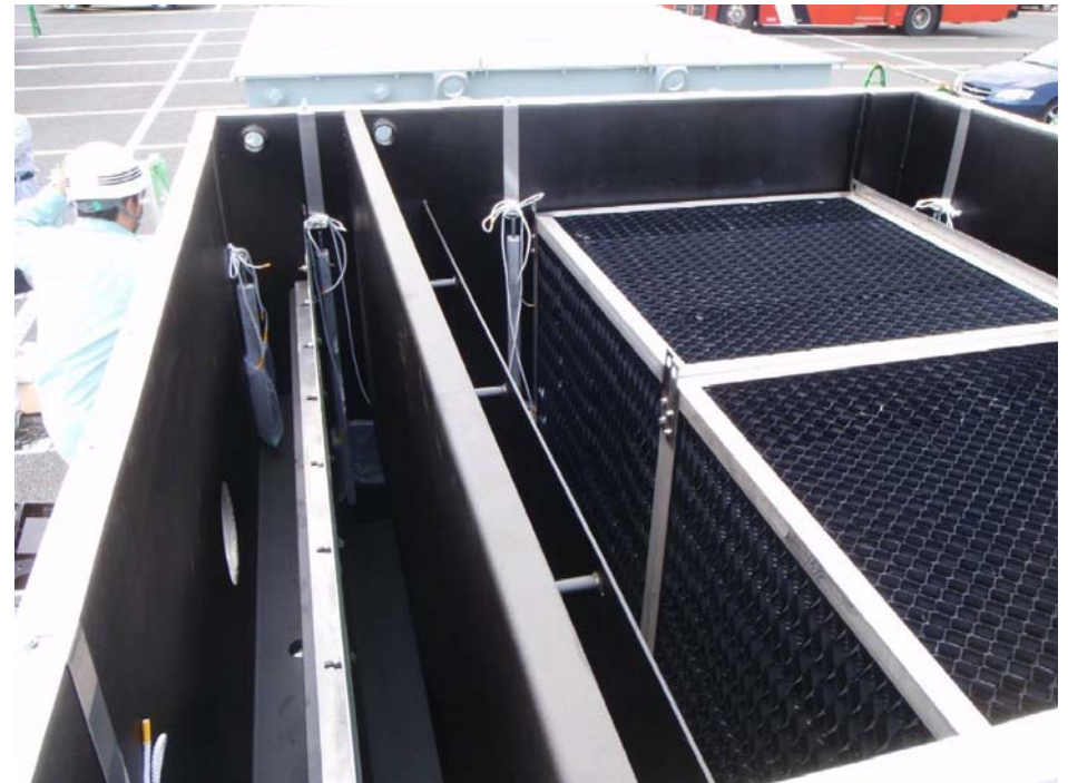
油分分離装置内部
