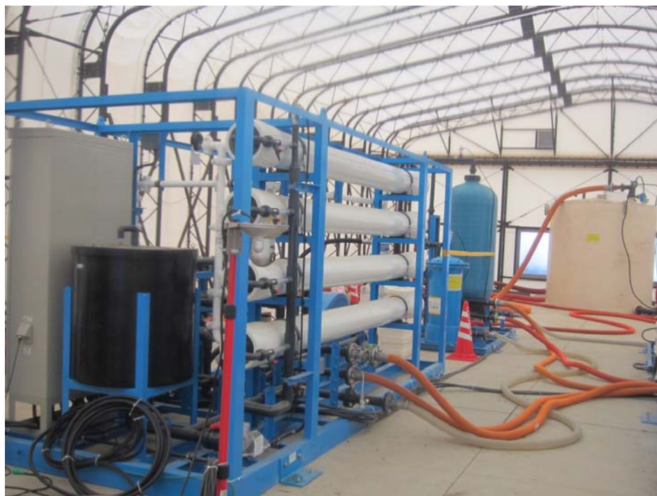
淡水化装置（ROモジュール）
