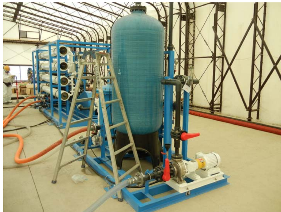
淡水化装置（ろ過装置）
