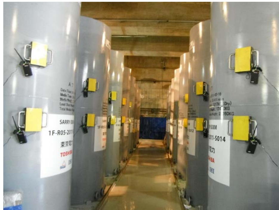
第二セシウム吸着装置（設置状況）その2
