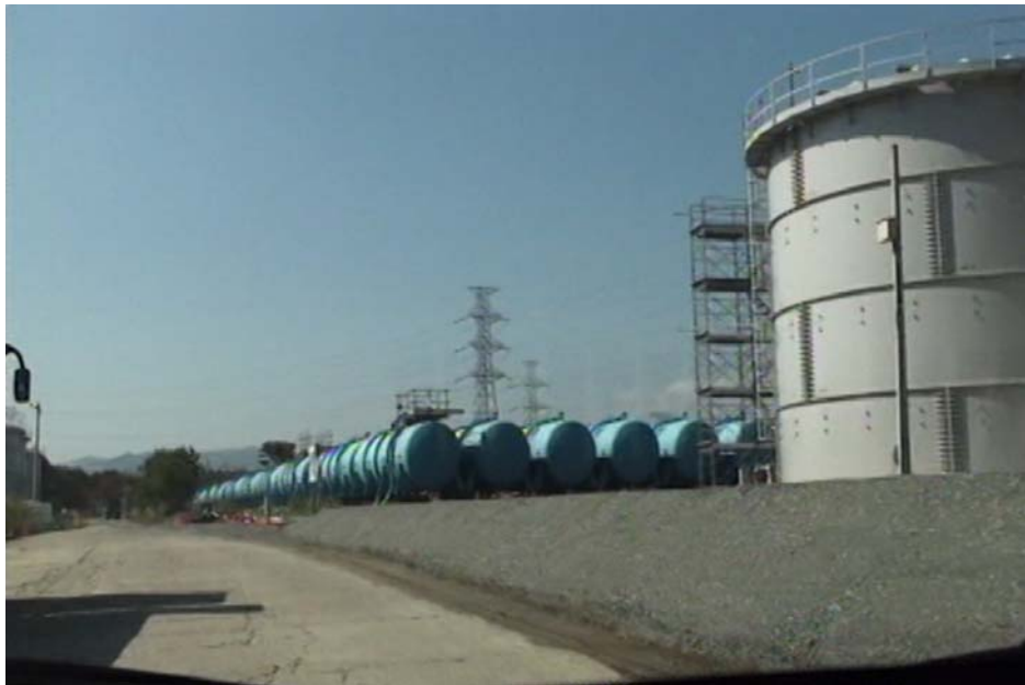
RO濃縮水貯蔵タンク その1
