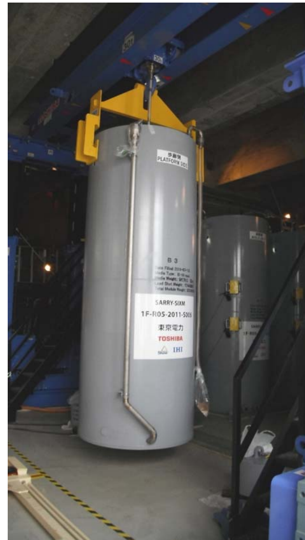
第二セシウム吸着装置（ベッセル設置）
