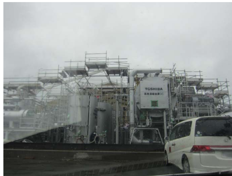
蒸発濃縮装置 その2
