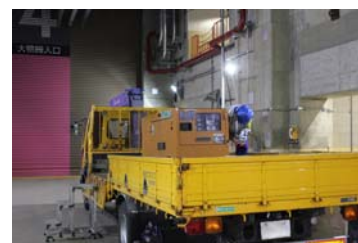
予備電動機（模擬）の搬出（4号機タービン建屋）
