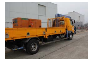
4号機海水熱交換器建屋への搬送
