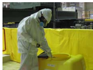
原子炉建屋（仮設タンク）への送水状況（2号機）
