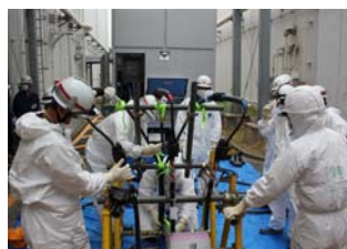
電源ケーブルの接続（2号機）
