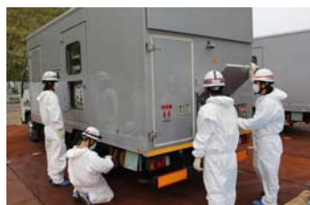
電源車の配備（4号機）
