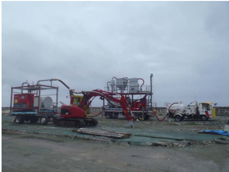
集塵作業状況
