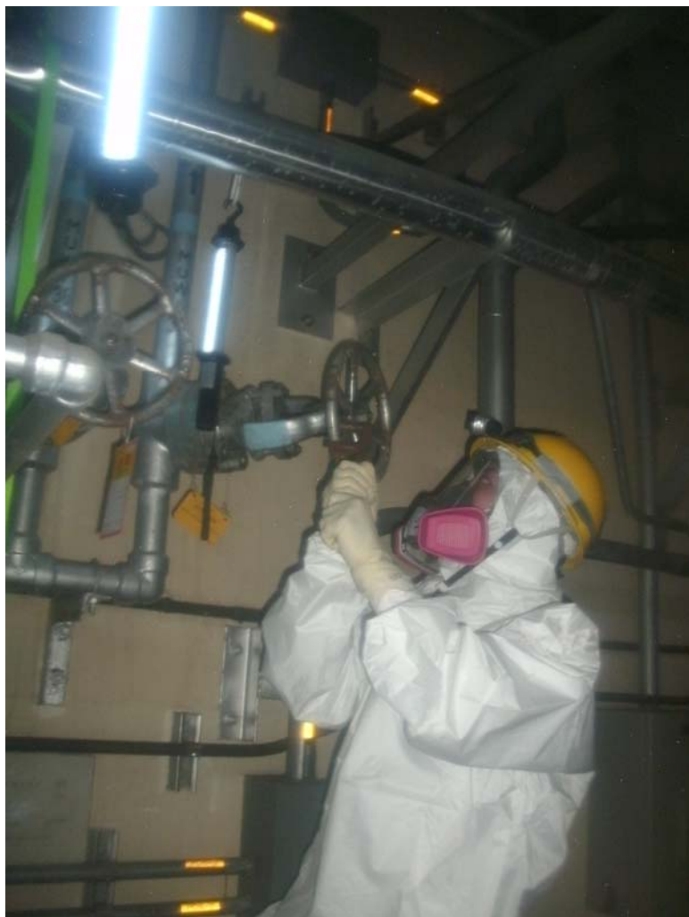
補給水系のラインナップ、弁操作作業
