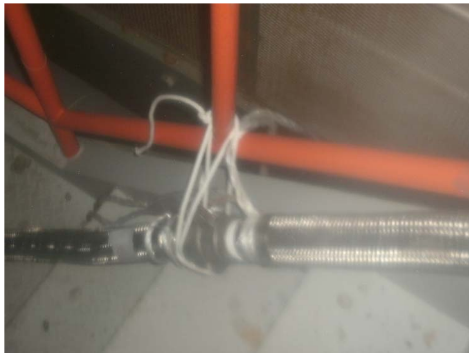
フレキシブルホースの敷設
