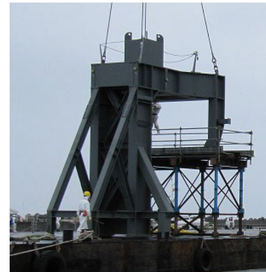
鉄骨柱の陸揚げ(平成23年7月26日) 撮影:東京電力株式会社
