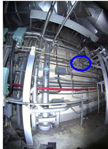
補給水系の弁 (②の場所)
