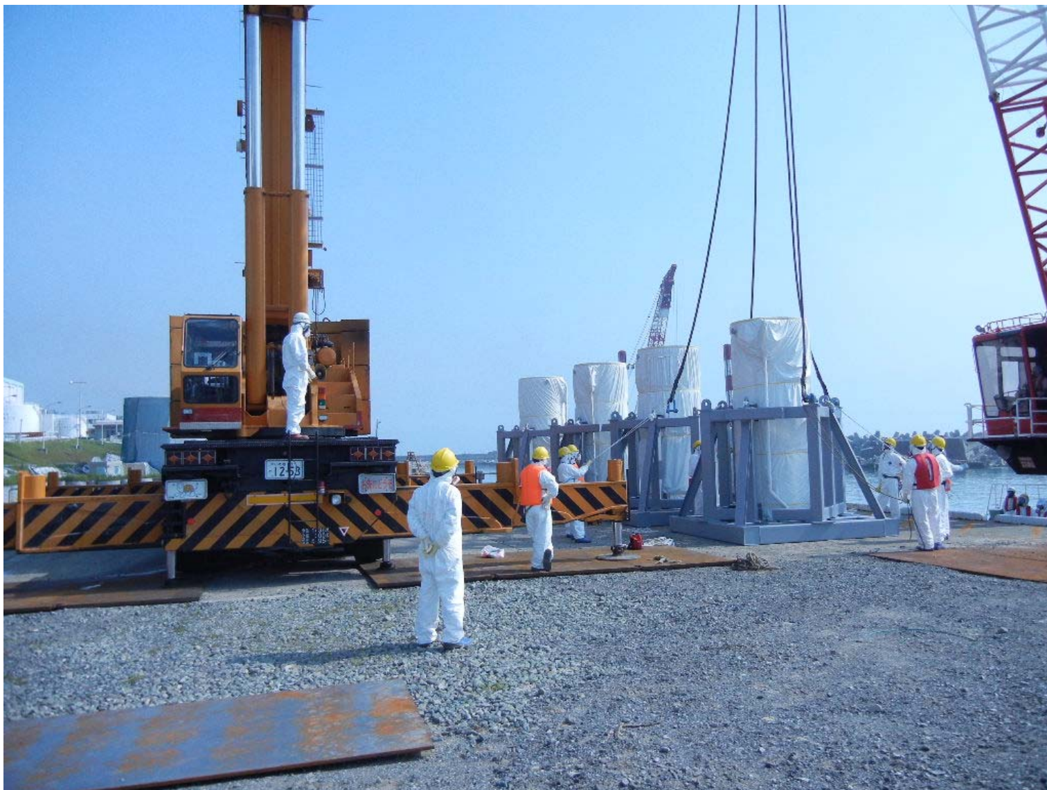
第二セシウム吸着装置(サリー)の陸揚げ後
