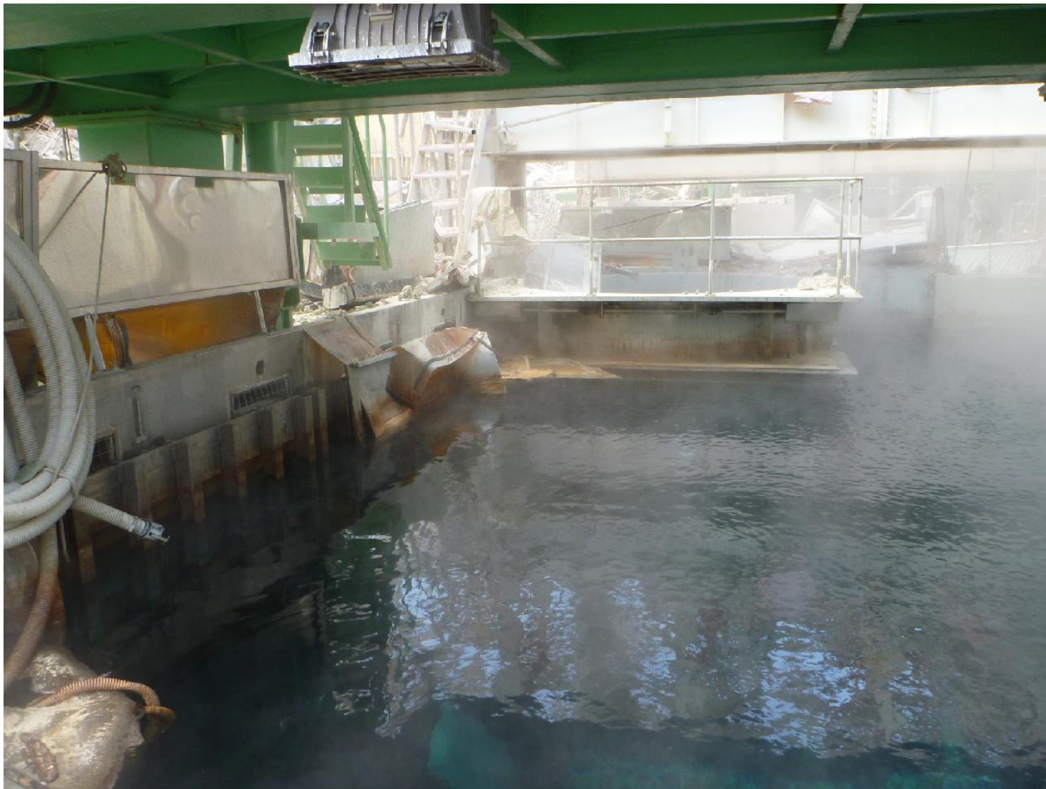
福島第一原子力発電所4号機 原子炉建屋5階 使用済燃料プール
