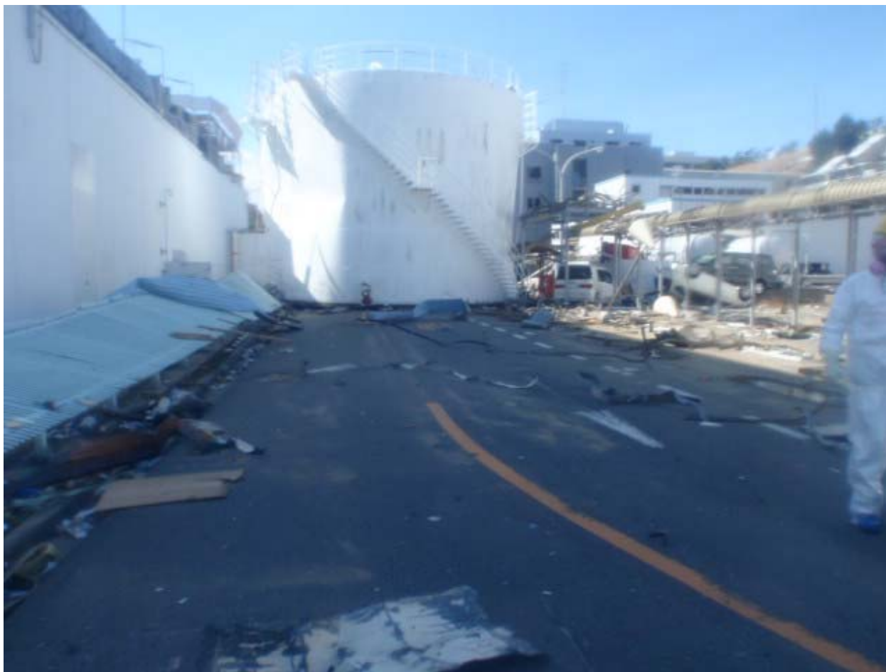
津波で流されたタンク(11ページ)
