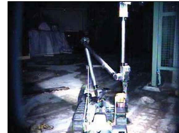
① 原子炉建屋北側二重扉入口 線量 84.9mSv/h, 温度 29.2°C 湿度 46.23%, 酸素濃度 20.9%
