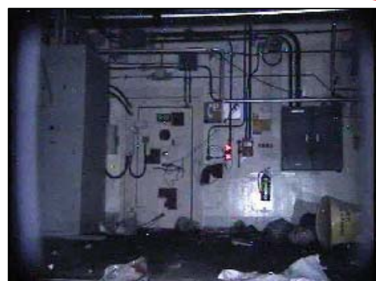
⑨ 西側エアロック前 線量 88.4mSv/h, 温度 30.2°C 湿度 37.6%, 酸素濃度 20.9%
