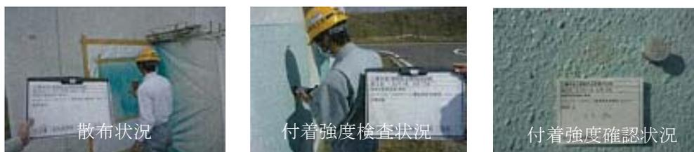
写真-6 散布状況と付着強度検査状況(外壁(塗装仕上げ)面)
