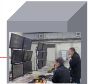
遠隔操作室 (事務本館)
