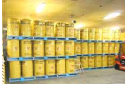
ドラム缶保管状態 (~6棟)
