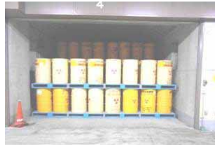
ドラム缶保管状態 (7, 8棟)
