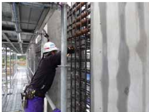
②西側3階壁配筋状況
