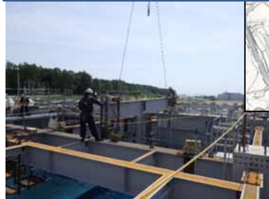
③西側4階鉄骨梁建方状況
