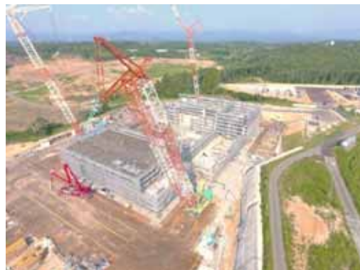
①工事エリア全景
