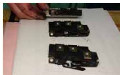
損傷の確認された整流器 (4月5日)
