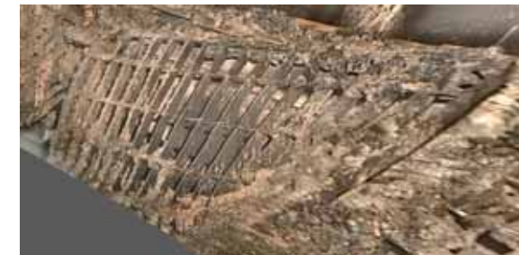
参考：プラットフォームのグレーチング
