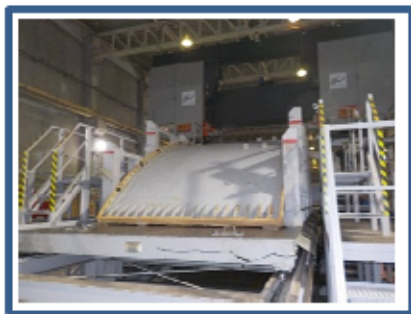
タンク片切断作業
