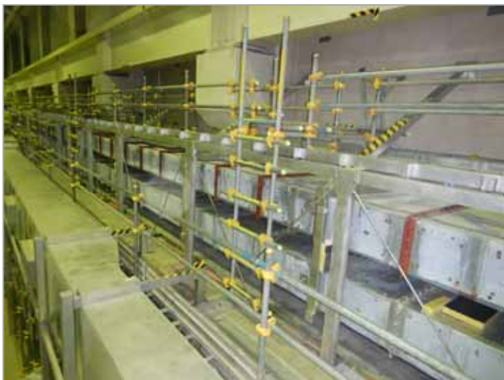
③保温材取外し箇所
