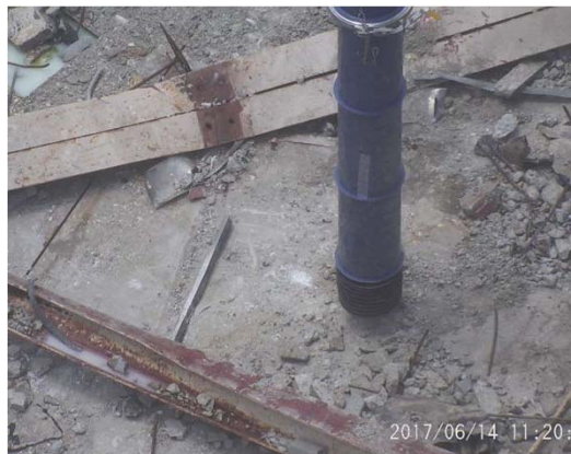
吸引装置によるガレキ撤去の様子
