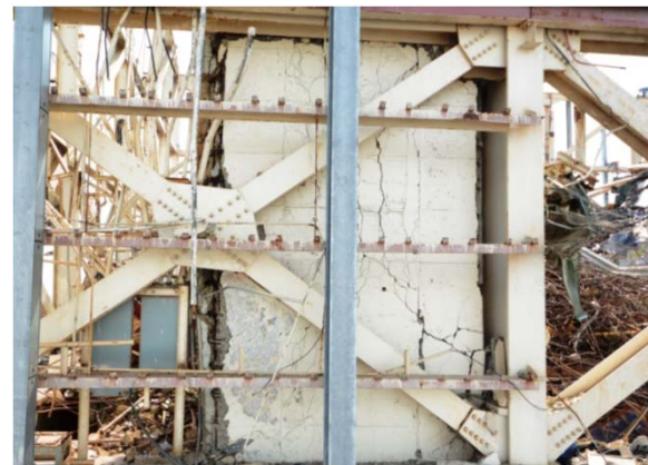
西面の壁状況
