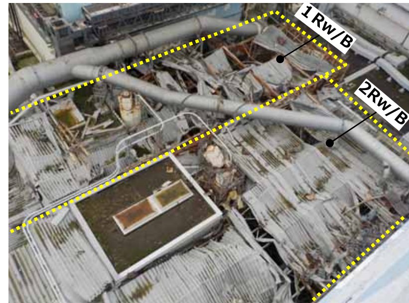
1,2号機Rw/B屋根の状況
