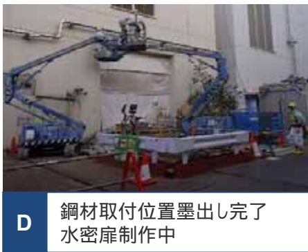
D 鋼材取付位置墨出し完了 水密扉制作中
