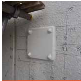
C 鉄板による 閉塞完了
