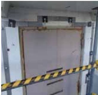
B 鋼板取付用の 枠材設置中
