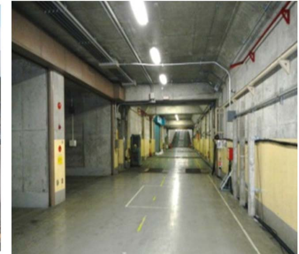
地下貯蔵庫通路
