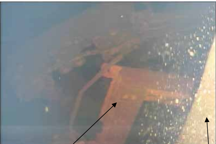
ペDESTアル開口部 側壁 プラットフォームフレーム
