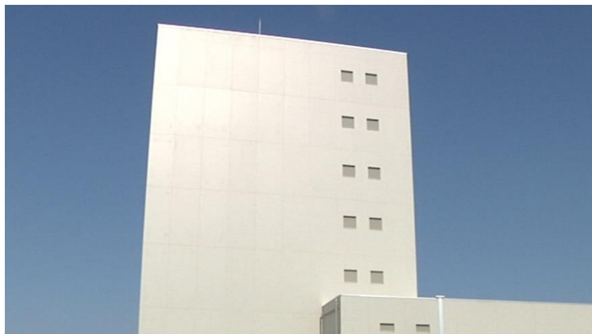
大型休憩所 (外観)
