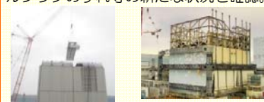
< パネル取り外し > < 建屋カバ―解体状況 >
