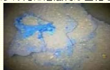
< 1号機格納容器底部 >
