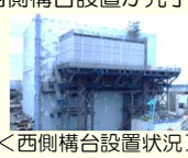
< 西側構台設置状況 >
