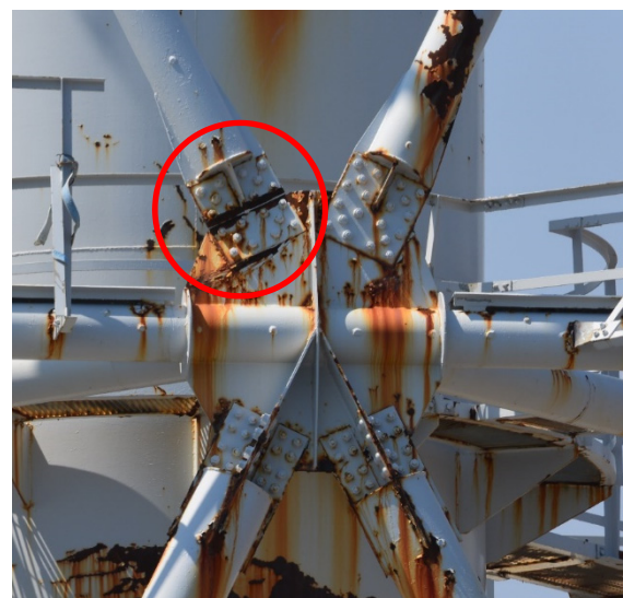
東面(GL+45m付近)
