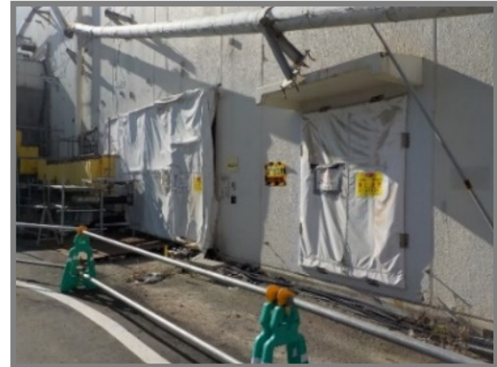
写真(a) 対策箇所の現状①
