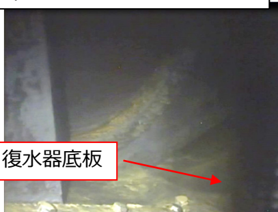
1号機H/W天板下部の水抜状況
