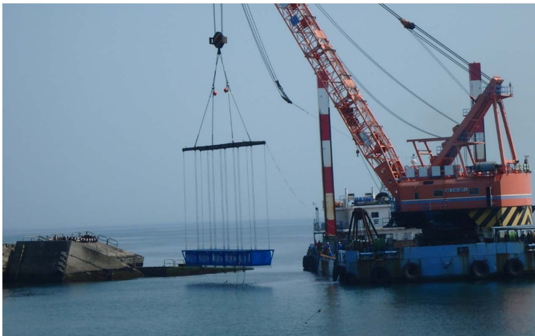
設置作業状況(遠景)
