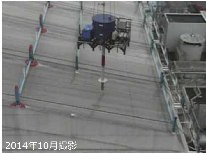
飛散防止剤散布状況（屋根パネル取り外し前）
