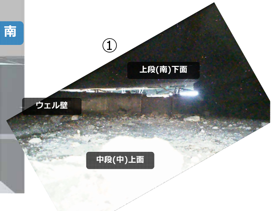
中段北側より撮影(北⇒南)
