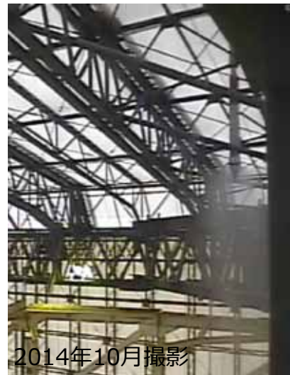
飛散防止剤散布状況（屋根パネル取り外し前）
