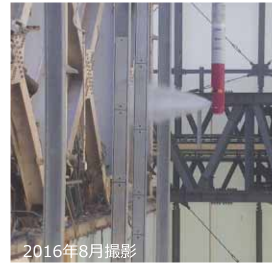
飛散防止剤散布状況 (壁パネル取り外し前)
