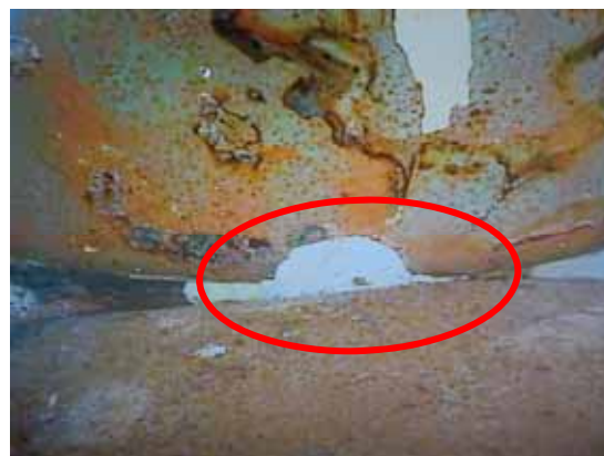
【 部】突起物切断，内面肉盛り溶接 外部あて板溶接 + パテ補修
