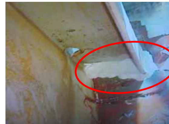
【 部】内面肉盛り溶接 + パテ補修
