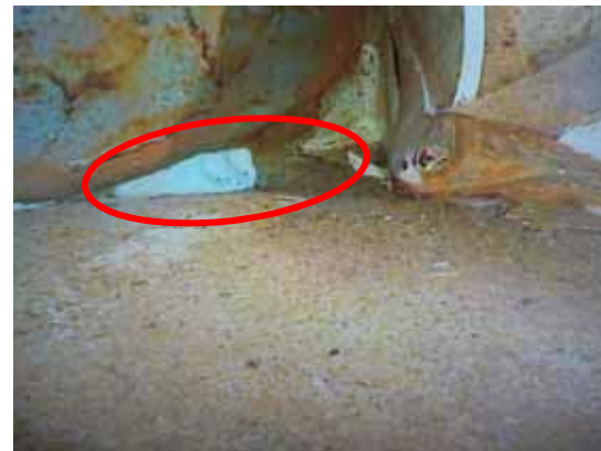
【 部】内面・外面肉盛り溶接 + パテ補修
