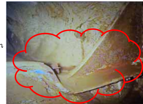
【部】(矢視C) 変形した下部補強板
